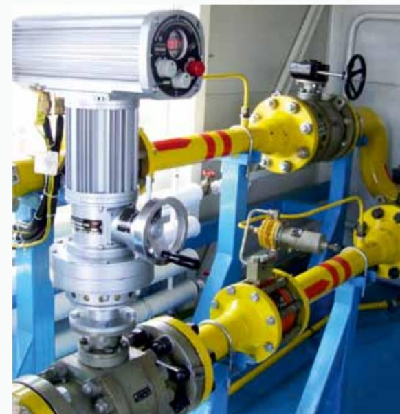
Рис.5. Поворотный электропривод РэмТЭК-02.П.250, Блок редуцирования газа, площадка Боатасино
