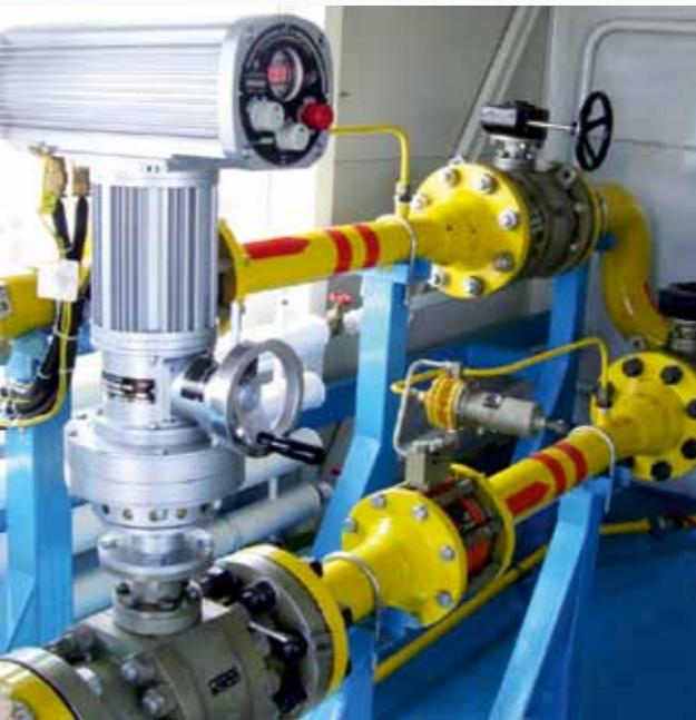
Рис.5. Поворотный электропривод РэмТЭК-02.П.250,
